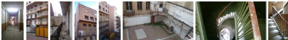
Estado Actual - I 01 Pasillo conector entre edificios MAL ESTADO
