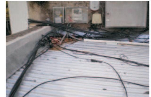
Se aprecia una CGP, caja de conexiones de Antel, dos contadores y una sirena.
