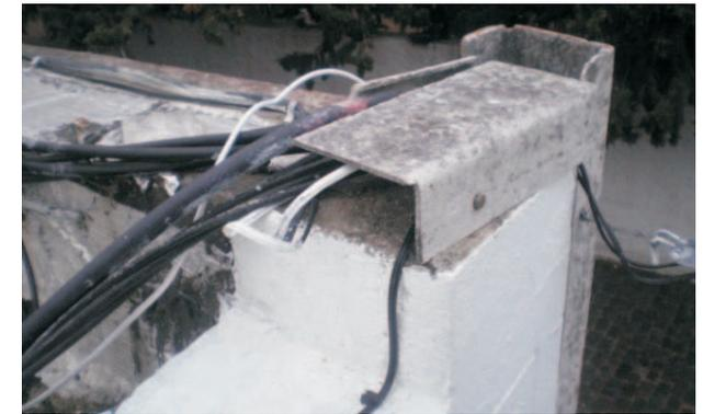
Además de UTE, por los ductos de fibrocemento que ellos colocaron hoy coexisten cables de teléfonos de Antel, se aprecia una rienda para el tendido de Antel afirmada en los soportes del ducto colocado por UTE, plastiducto de agua potable que metieron por el ducto con los cables para ocultar el caño que llevan agua del contador de OSE a apartamentos de la parte de atrás del predio y un cable coaxial (blanco) de Direct TV.
