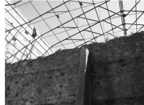
Img. 07- CS Carboneras. Muro interior con contrafuerte de hormigón.
