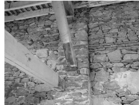
Img. 28- AERJ Administración / Edificio del Reloj. Apoyo de vigas de madera en planchuelas.
