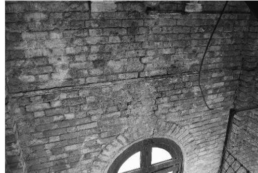
Img. 27- AERJ Administración / Edificio del Reloj. Grieta en el muro de la torre, vista interior.
