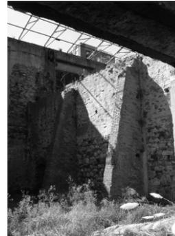
Img. 06- CS Carboneras. Muro interior con contrafuerte de ladrillo.
