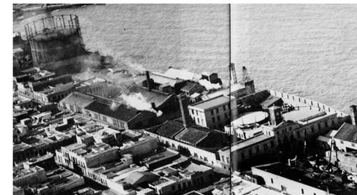
Acercamiento de la imagen aérea de fines de la década del 30 en la que pueden apreciarse varios de los componentes analizados (Administración, Carboneras, Retortas, Taller de Cocinas, etc.) y también la estructura de uno de los Gasómetros desaparecido por el trazado de la Rambla Sur.
