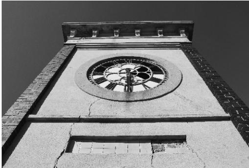
Img. 26- AERJ Administración / Edificio del Reloj. Grieta en el muro de la torre.
