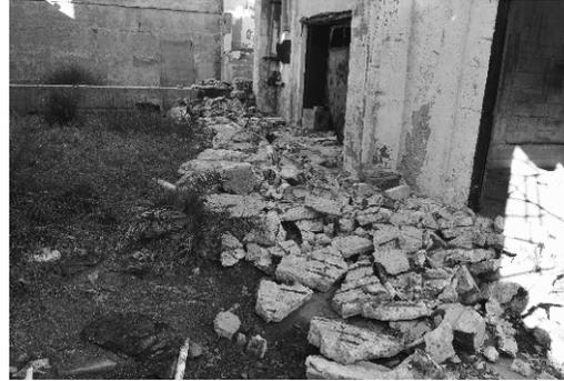
Img. 60- OS Depósito 02, caída del alero.
