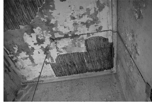
Img. 25- AERJ Administración / Edificio del Reloj. Cielorraso de varillas de madera.
