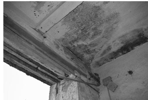
Img. 46- TCEB Talleres de Cocinas / Edificio Blanco. Vista de dinteles con perfil metálico.
