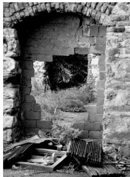
Img. 09- CS Carboneras. Vano parcialmente tapiado.
