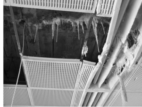
Img. 52A- OS Edificio Rojo. Detalle del estado del cielorraso.
