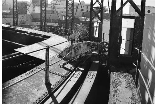
Img. 73- G.SM Gasómetro. Detalle de la cubierta con mecanismos de rodamiento.
