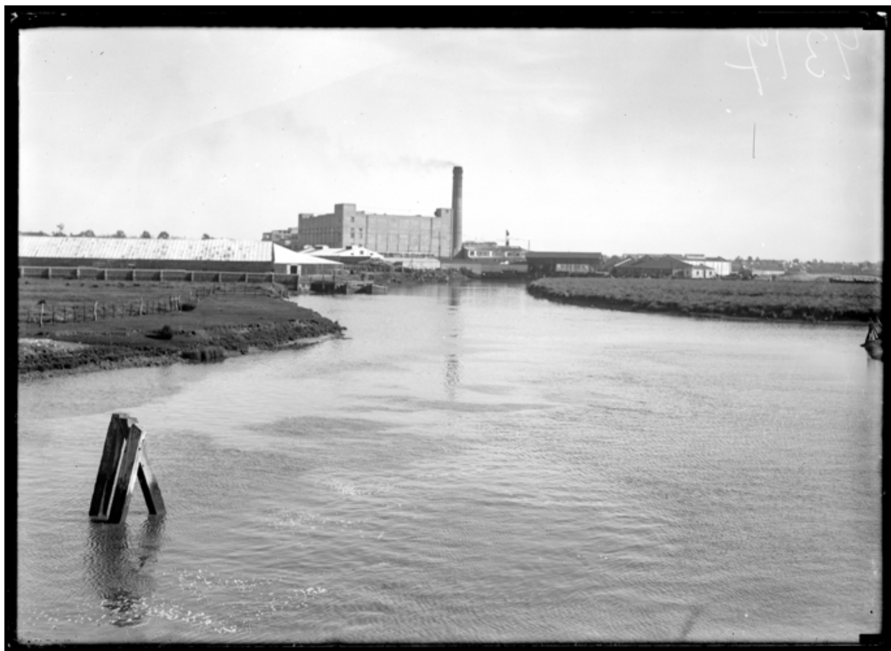
Arroyo Pantanoso con Frigorífico Artigas. 1926.
