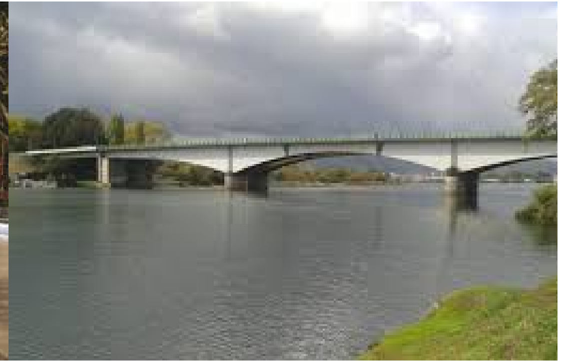
Nuevo Puente Vehicular
