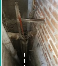
Modificación del sistema de desagüe de las cocinas y grasera
