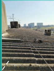
Recuperación y mejora del cerramiento horizontal, azotea
