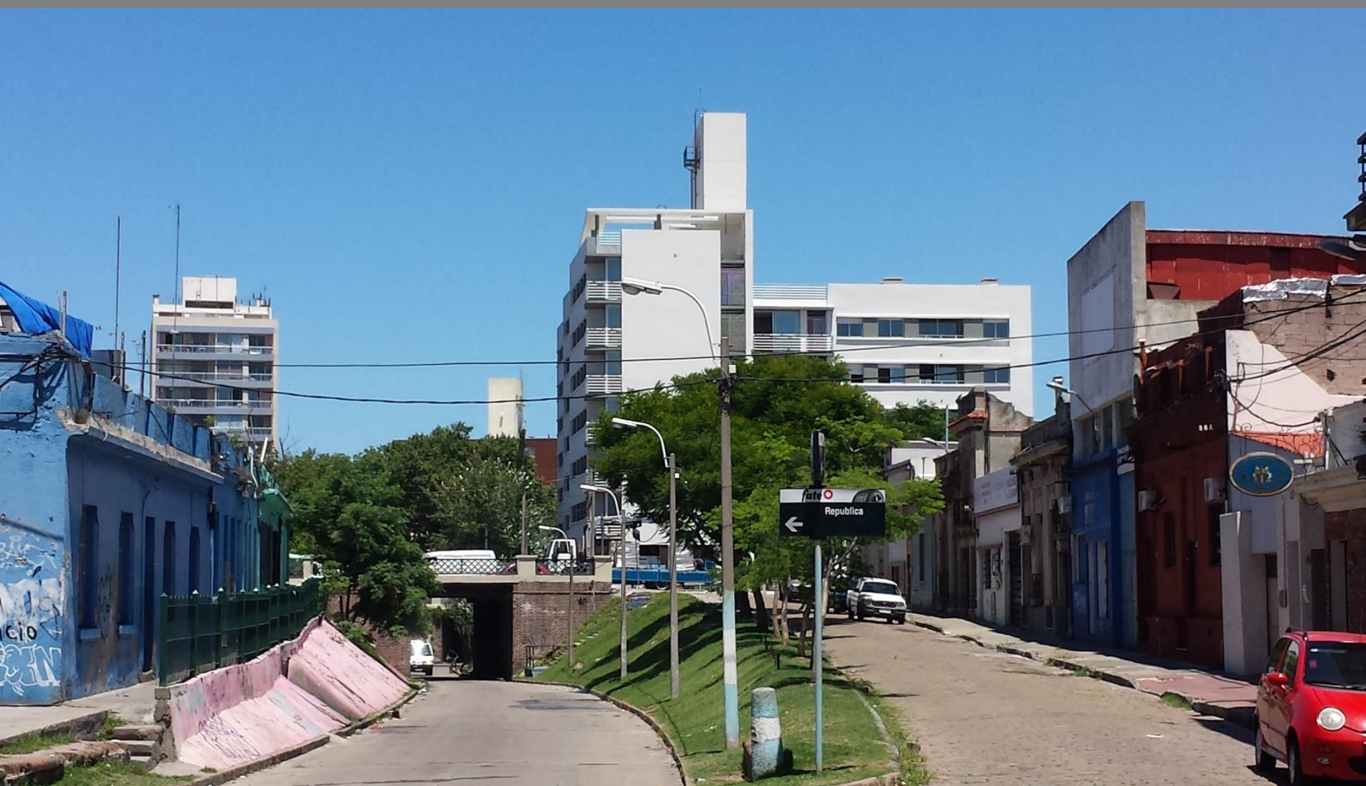
Cooperativa Nueva Era. Arenal Grande y Galicia. (Años: 2010 proyecto, 2018 final obra)
