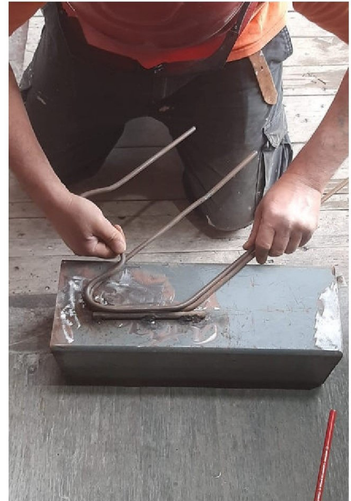
Los nuevos hierros de las armaduras de las molduras siguen la forma de la moldura a reconstruir.
