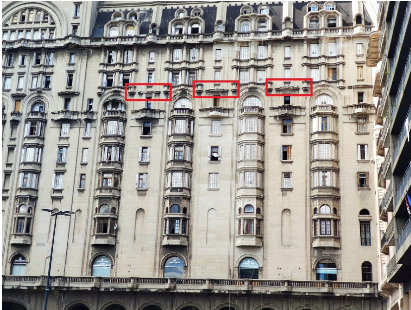
Foto de la fachada de Plaza Independencia tomada durante el proceso de restauración de las molduras.
